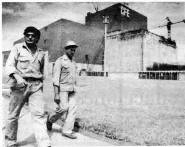
La planta nucleoelectrica de Laguna Verde comenzará a operar, por fin, tras su puesta en marcha en noviembre de 1988.
